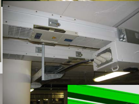
Danube House Realizace a projekt odbočného místa na trase LD5413 s napojením na kabelový žlab.
